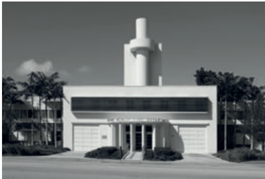
Bild 14. Feuerwache. Miami. USA. 1939. R. L. Weed, E. T. Reeder. Foto: J. Molitor, 2013.
